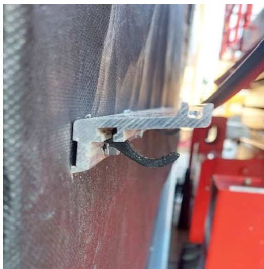
Obrázek 3: schéma vložení háčku do nosné lišty
