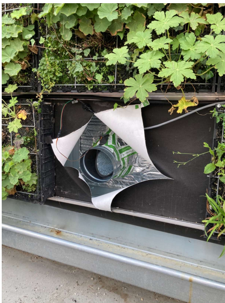
Obr. Montáž regulačních klapek pro vzduchovou mezeru
